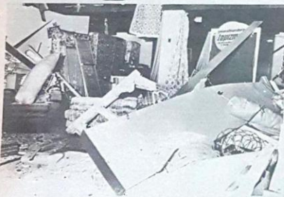
Un ejemplo de tipografía, situado al lado del TNT, también resultó con serios daños.
