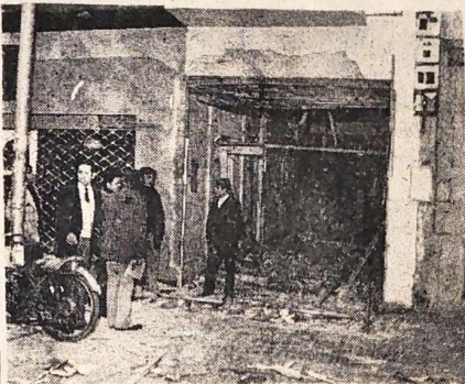
Algunos transeúntes observan los daños producidos por el atentado en local teatral. Inmuebles vecinos resultaron afectados también por el estallido.
